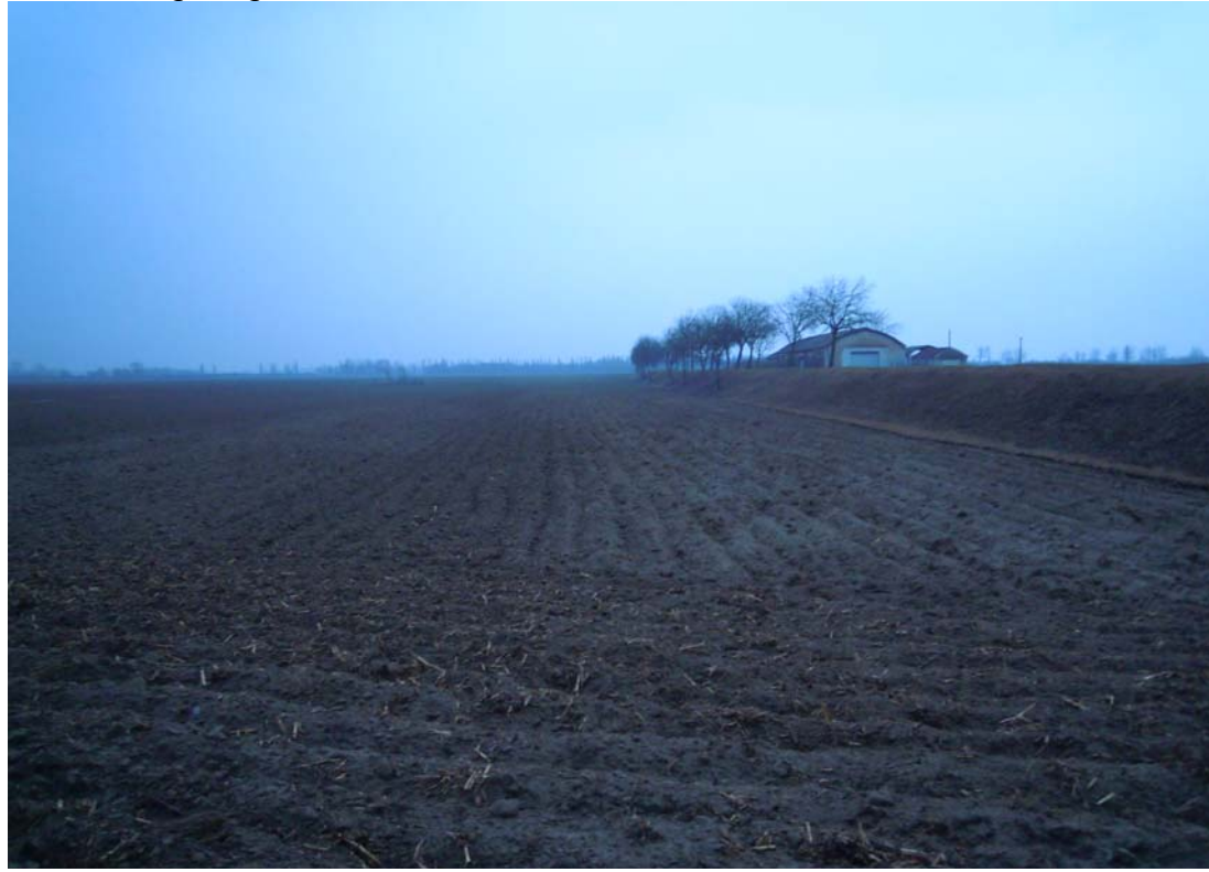
FOTO 1: Argine golenale lato fiume in località C.na Motta
